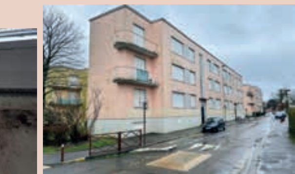
Les travaux vont commencer dans trois immeubles, avenue Saint-Exupéry.
