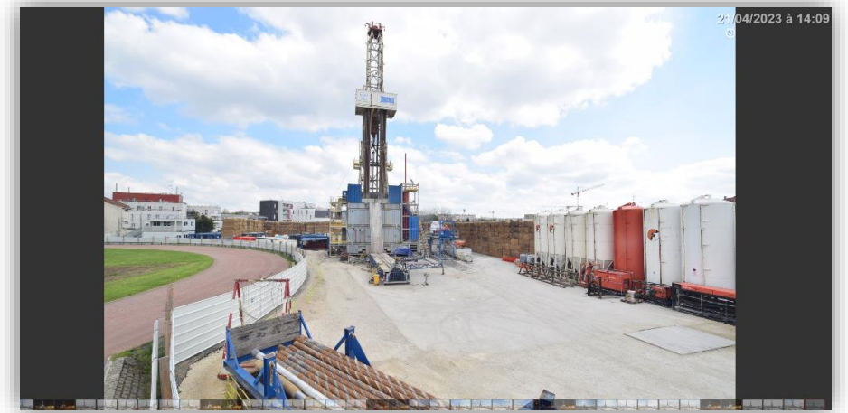
Timelapse pour suivre l'avancée des travaux en temps réel pendant toute la durée des travaux
