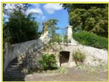
© Escalier à double révolution, Vestige de la Demeure Arouet
